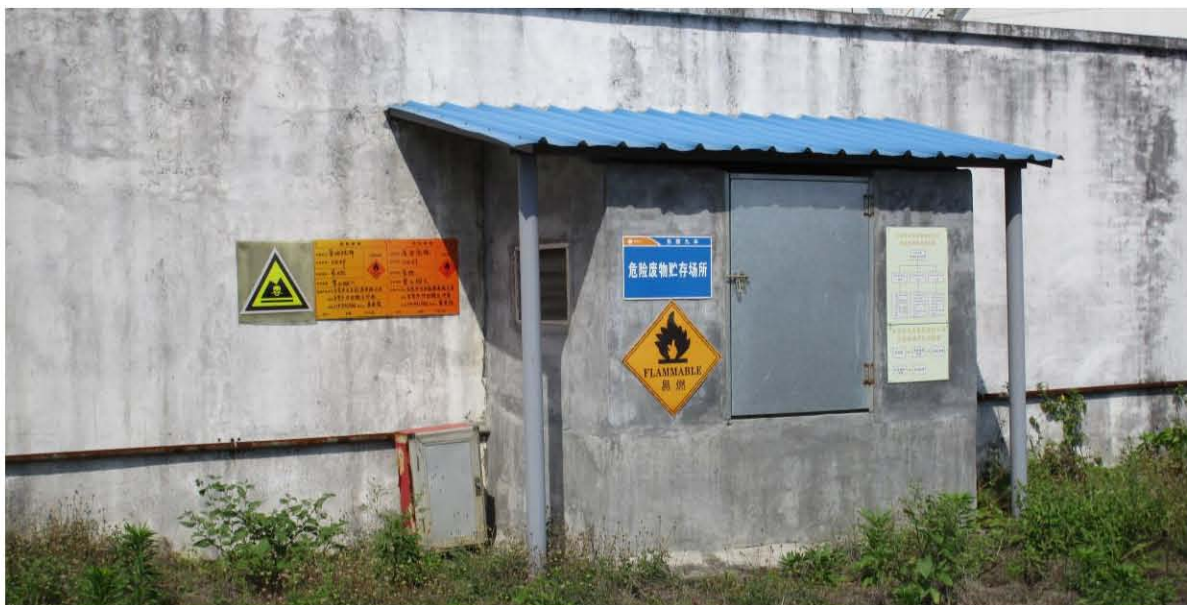
照片 10-5 危险废物临时堆放场所
