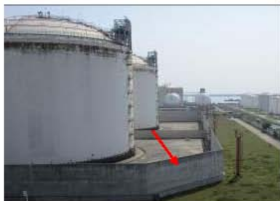
照片 4-3 81900\text{m}^3 防火堤围堰
