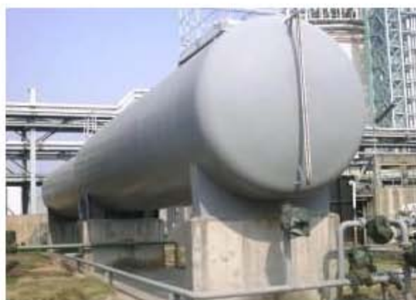
照片 4-6 200\text{m}^3 事故应急卧罐
