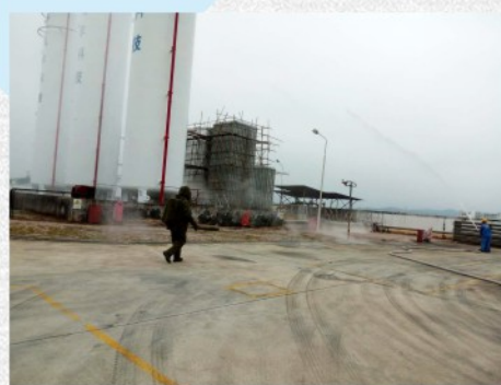
丁立运穿好防冻服在水带掩护下进入现场查看情况
